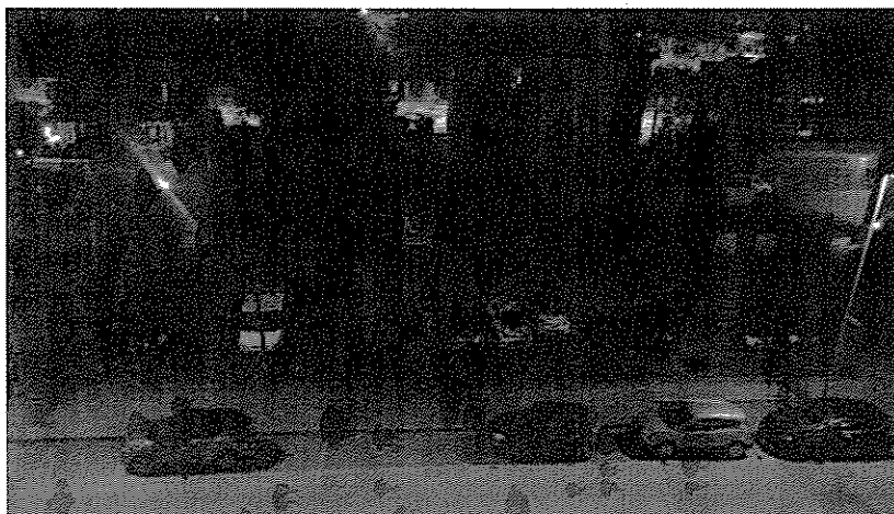
Piazzale Croce Rossa (mancanza illuminazione)
