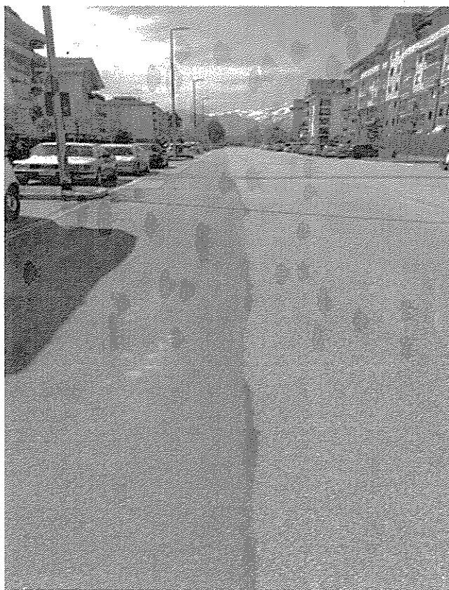
Via Vinaj (ripristino pavimentazione a regola d'arte)
