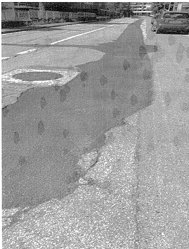
Via Fenoglio (ripristino pavimentazione non regolare)
